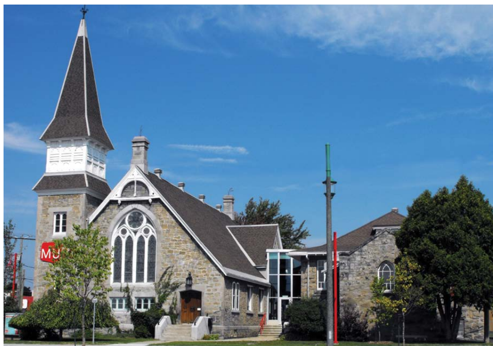
VUE EXTÉRIEURE D'ENSEMBLE APRÈS LES TRAVAUX. Photo : Massicotte & Dignard architectes
