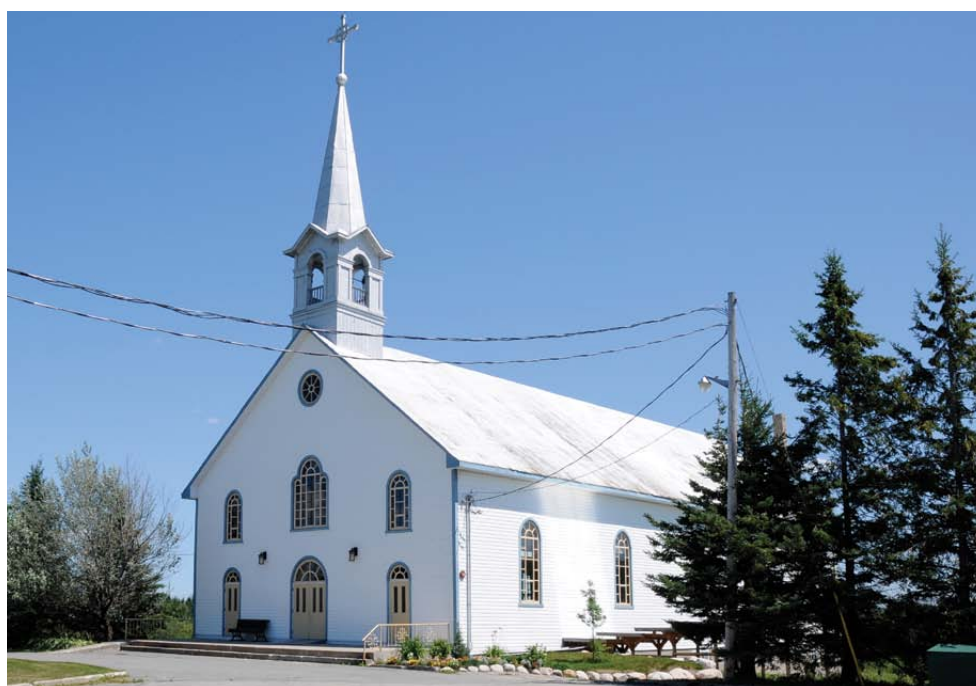
ÉGLISE SAINT-LUC TRANSFORMÉE EN CENTRE COMMUNAUTAIRE DE LA MOTTE.
