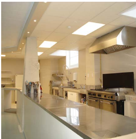
CUISINE COMMERCIALE AMÉNAGÉE AU SOUS-SOL. Photo : Centre communautaire de La Motte
