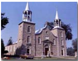
Façade Photo : François Brault
