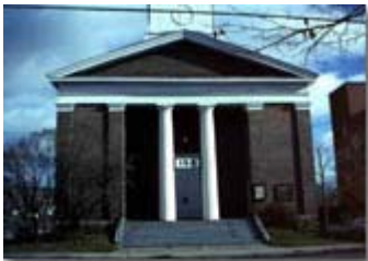
Colonnade de l'entrée Photo : François Brault
