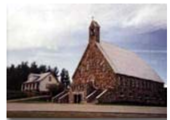
Ensemble extérieur de l'édifice
