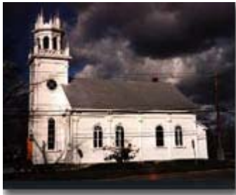
Élévation latérale Photo : CPRQ Église de
