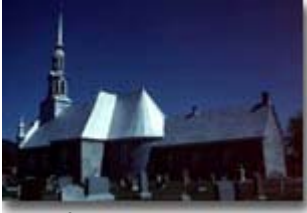
Élévation extérieure Photo : François Brault
