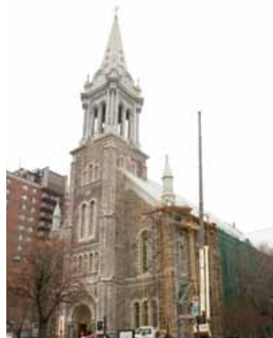
L'église Immaculée-Conception à Montréal, où s'est tenue la conférence de presse, bénéficiera d'une aide de 245 000 $ pour la restauration de sa toiture.
